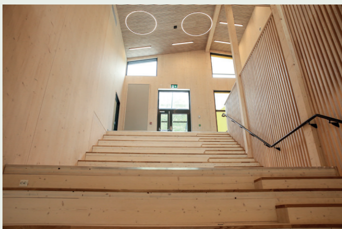
Fra amfi-et over to etasjer innenfor hovedinngangen. Amfi-et er bygget i massivtre. Vi ser eksponert massivtre på vegger og trespiler i tak og på vegger.
